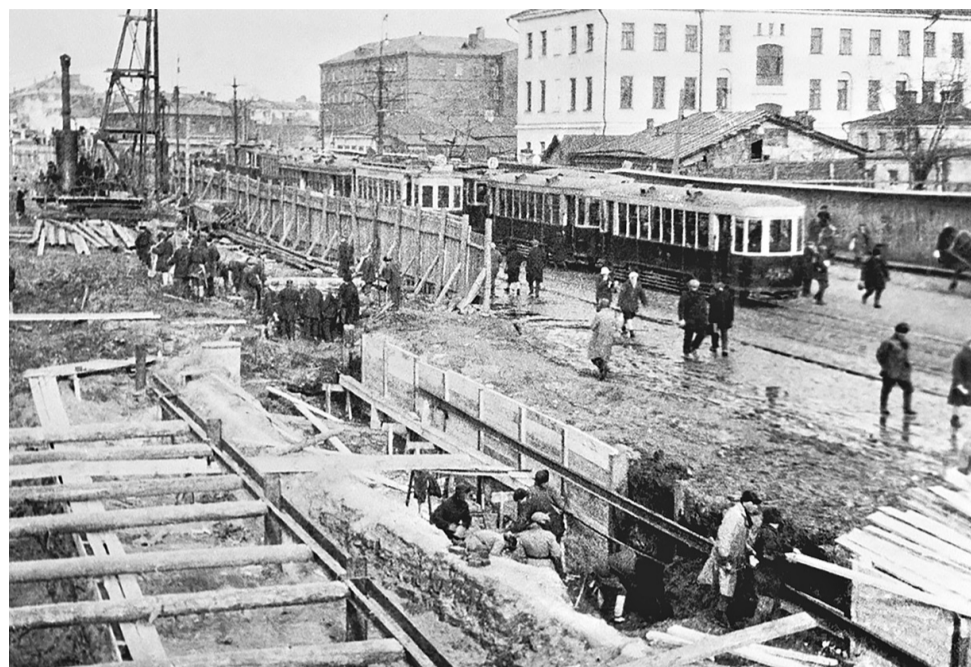
Работы открытым способом на Краснопрудной улице. Проходка шахты № 26. 1933 год
